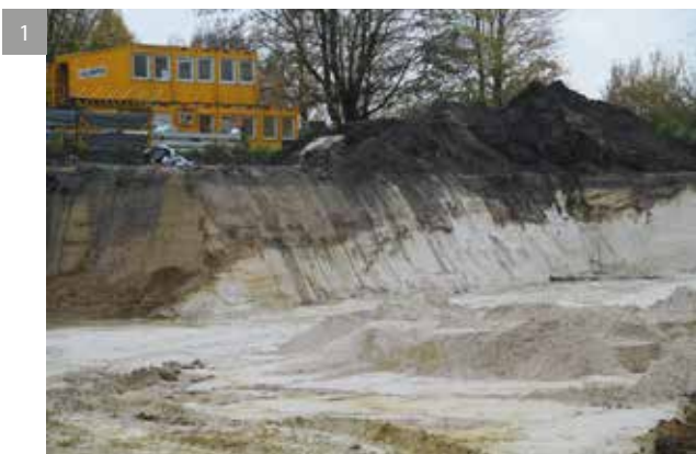
Fig. 1. Zuidwand van de bouwput gelegen aan de Beukenbergweg (schoolterrein van de VIIOP Humaniora, Tongeren): erosief contact (insnijding) tussen in situ wit zand en leem (foto: R. Dreesen).
